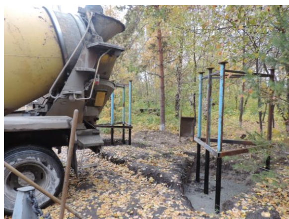
Заливка бетоном для устойчивости всей конструкции
