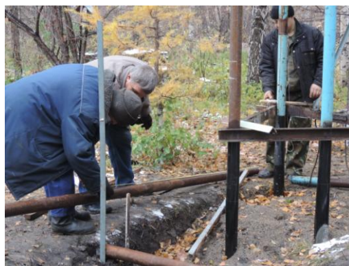
Сварка деталей каркаса
