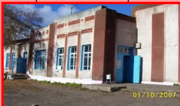
(здание бывшего маслозавода)
